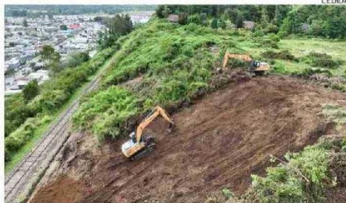
CON EXCAVADORAS HAN ESTADO REALIZANDO LOS CORTAFUEGOS.
