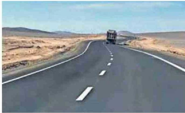
EL TRAMO SUMA 20 NUEVOS KILÓMETROS DE PAVIMENTO.
