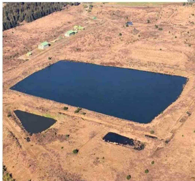
EN LA IMAGEN SE OBSERVA LO ÚNICO QUE QUEDÓ DEL FALLIDO RELLENO: UN ENORME HOYO LLENO DE AGUA.
