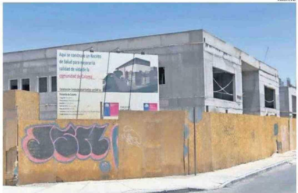
COMDES ESPERA QUE SE RETOMEN LAS OBRAS DEL CESFAM SURPONIENTE DE CALAMA.
