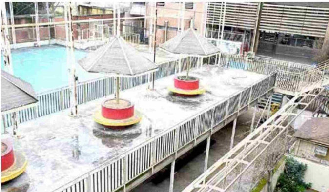
El sector donde se registró caída de menor fue reforzado adecuadamente.
