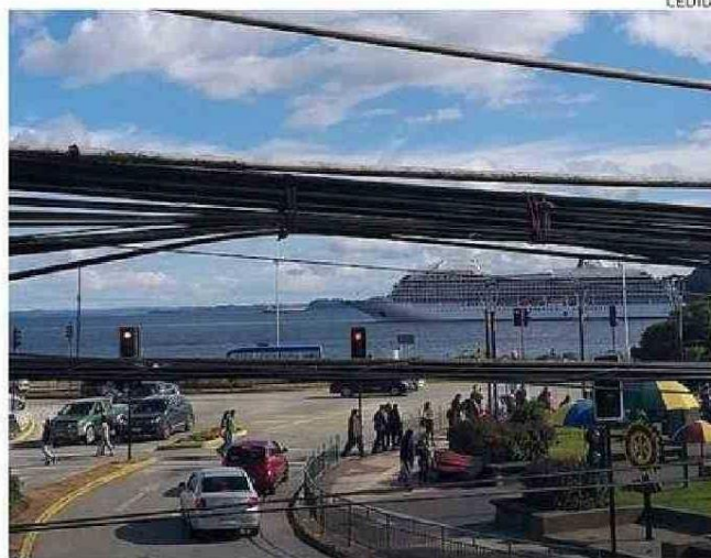
CAÍDA DE ÁRBOLES EN TEMPORALES AMENAZA SUMINISTRO ELÉCTRICO.
