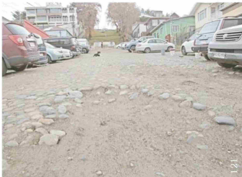
Un fuerte deterioro presenta el empedrado de calle Waldo Seguel de España al poniente, que ha obligado a los propios vecinos a tapar los hoyos.
