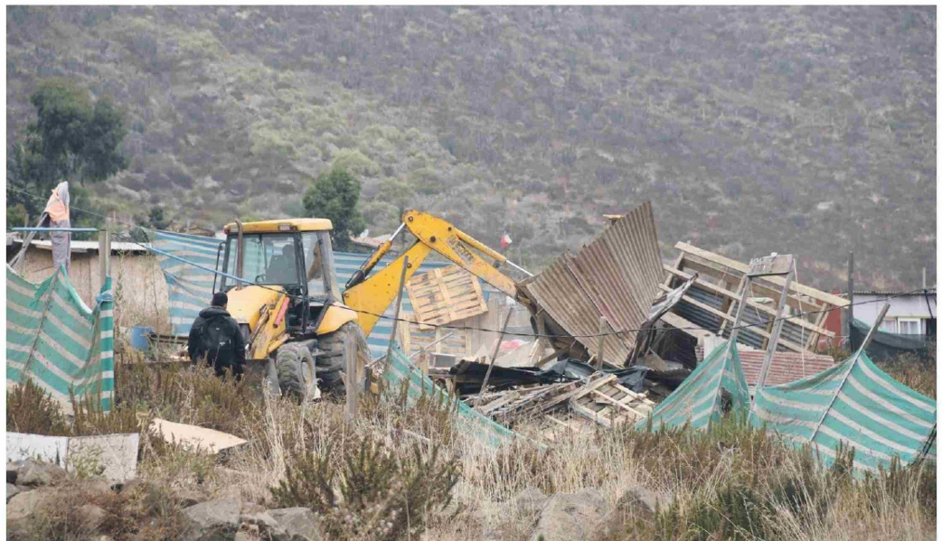
Imagen de la maquinaria iniciando el proceso de demolición de las primeras viviendas en el sector de La Rinconada
