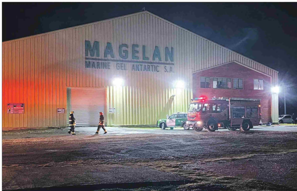
Dos trabajadores siguen internados por inhalación de gas.
