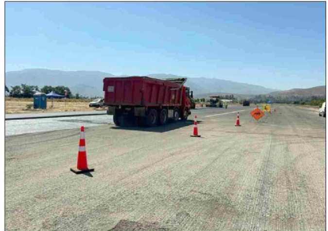
En plena ejecución están los trabajos en el aeródromo Víctor Lafón.
