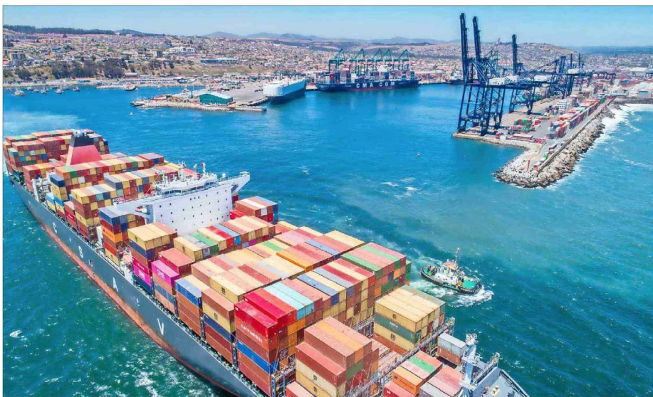
El Puerto Exterior, cuyo proceso de licitación se inició en enero, tendrá una capacidad total para seis millones de contenedores.
