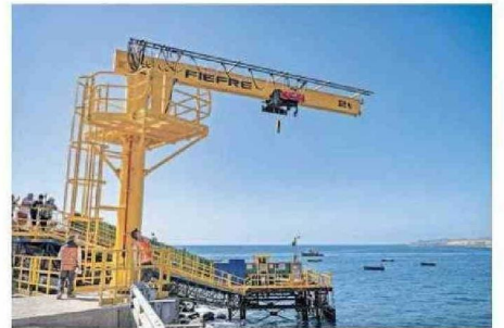
ESTA GRÚA TIENE UNA CAPACIDAD DE CARGA DE 2 TONELADAS.
