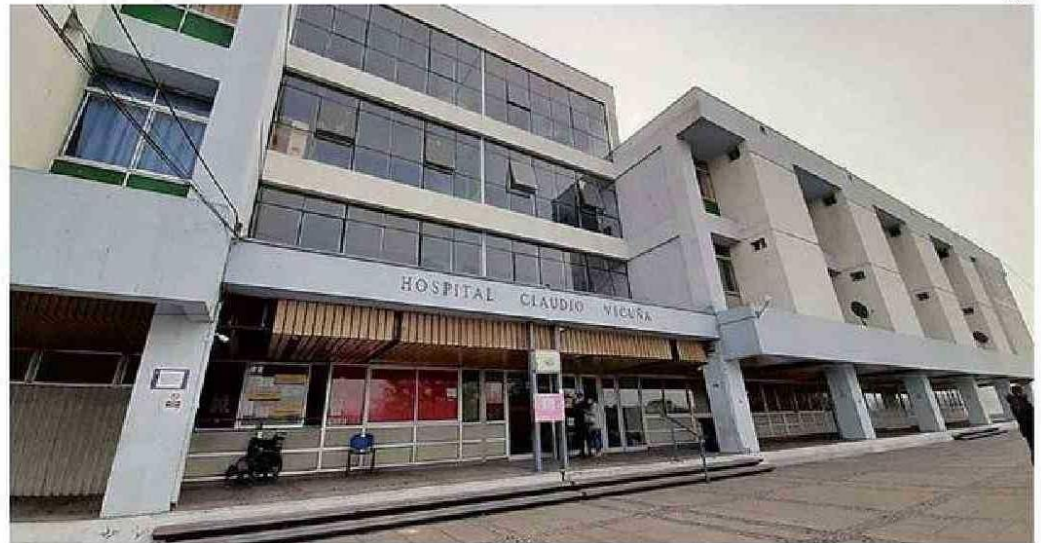
LA UNIVERSIDAD DE VALPARAÍSO QUIERE TRANSFORMAR EL EDIFICIO EN UN CAMPUS. HCV
