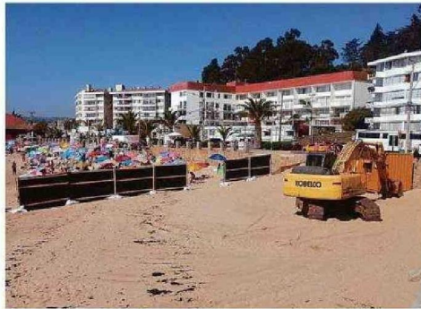
LA EMPRESA CONTRATISTA YA INICIÓ LA INSTALACIÓN DE FAENAS.
