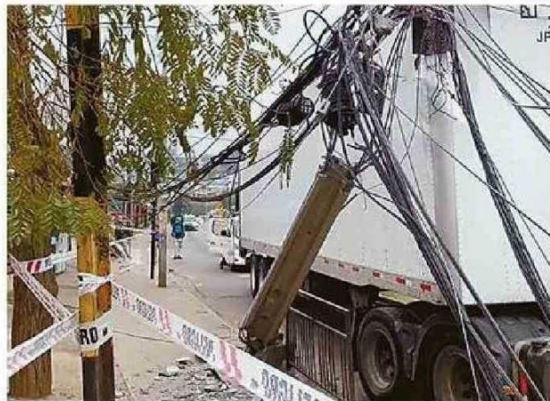
PASÓ A LLEVAR CABLES DEL TENDIDO ELÉCTRICO Y DE TELECOMUNICACIONES.
