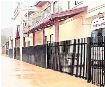
EL RECINTO LOTINO FUE INUNDADO POR LAS FUERTES LLUVIAS.
