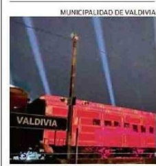
LA EX ESTACIÓN DE TRENES.
