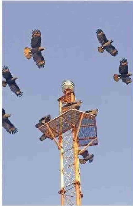
Caracaras sobrevolando las instalaciones del faro en isla Gonzalo.
