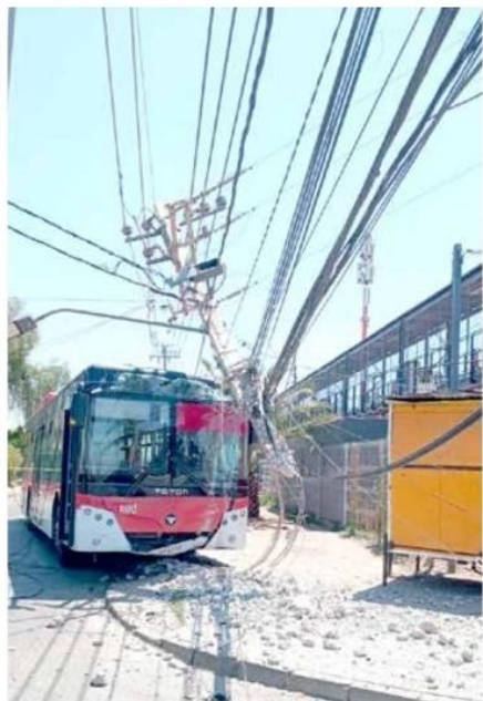
Hay vecinos de la Región del Maule que han debido soportar hasta 12 horas sin luz para la reparación de un poste chocado.
