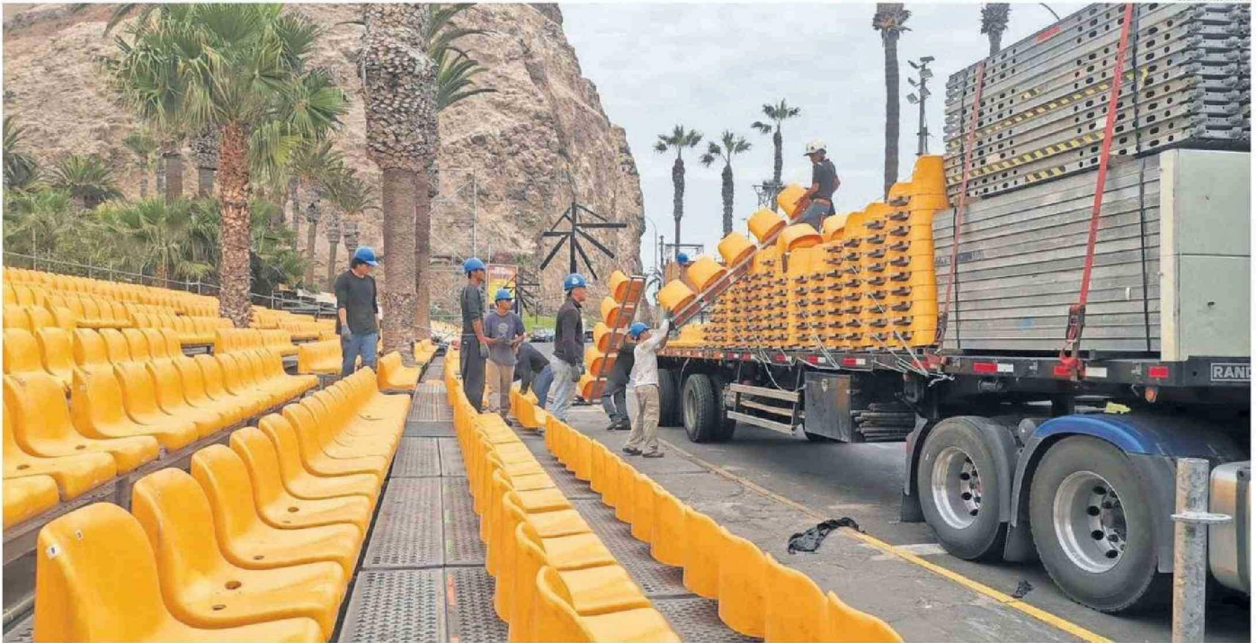
EL MONTAJE DE LAS GRADERÍAS, TARIMAS Y OTROS COMENZÓ ESTA SEMANA Y SIGUEN LOS TRABAJOS EN COMANDANTE SAN MARTÍN, POR LO QUE SE RECOMIENDA TRANSITAR CON PRECAUCIÓN.
