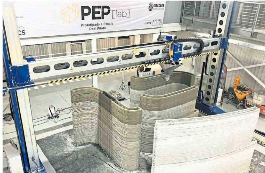
La vivienda es construida por una impresora industrial 3D ubicada en dependencias de la Universidad del Bío-Bío.
