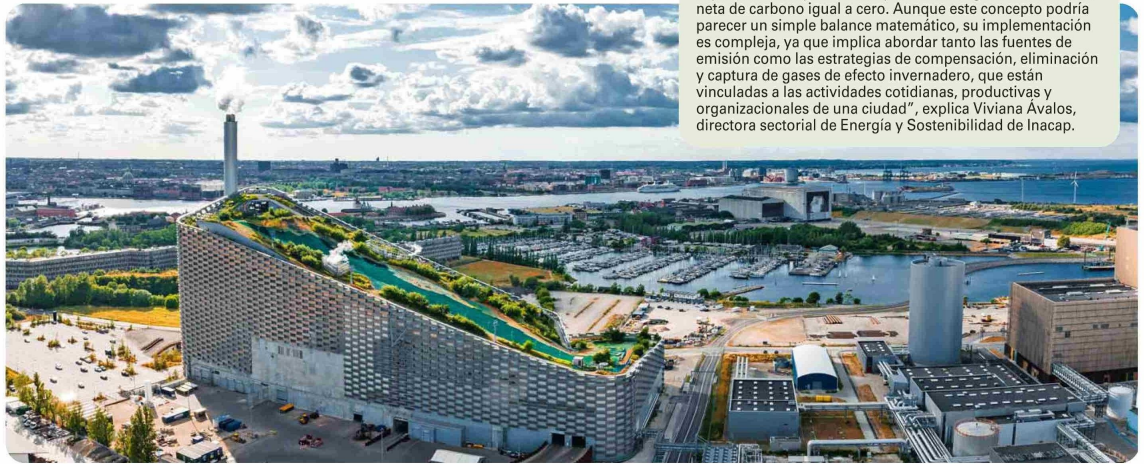
La capital danesa pasó de ser un pueblo de pescadores a un modelo para proteger el medioambiente. En la foto, CopenHill, una planta de conversión de residuos en energía.
