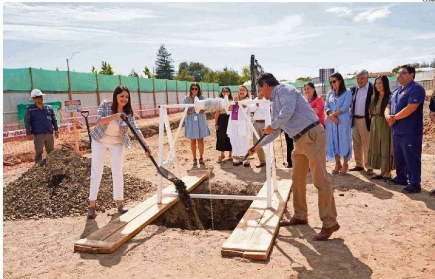
AUTORIDADES DIERON EL VAMOS A LA CONSTRUCCIÓN DEL CESFAM-SAR JOSÉ DURÁN TRUJILLO EN LA CAPITAL DEL PUNILLA.
