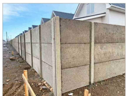
La Constructora Salfa ha incorporado 40 toneladas de plástico reciclado a sus elementos de hormigón. En la foto, las panderetas prefabricadas.
