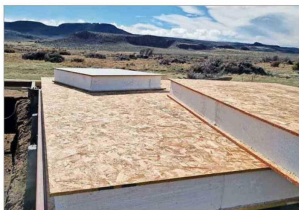
Los paneles SIP, en la imagen, que se utilizan para la construcción de viviendas privadas y sociales, entre otros.
