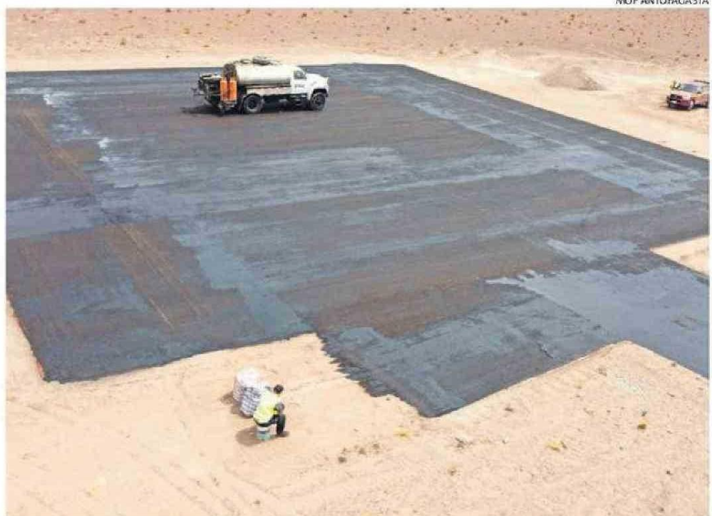
ESTAS OBRAS LE ASEGURAN CONECTIVIDAD AÉREA A LA ZONA CORDILLERANA DE LA PROVINCIA EL LOA.
