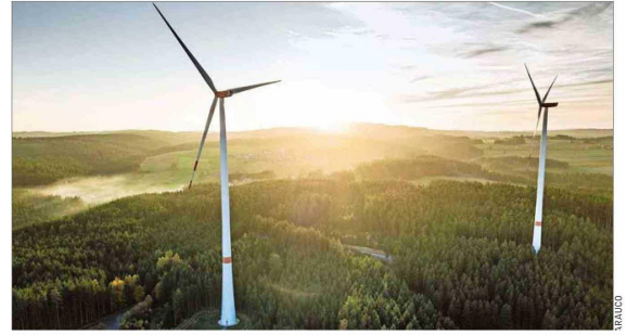
El proyecto Viento Sur considera la construcción y operación de un parque eólico compuesto por 43 aerogeneradores, con una potencia instalada del orden de 215 MW.
