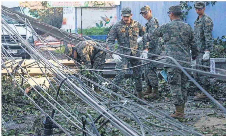
Personal del Ejército se unió ayer a los trabajos de los municipios y las empresas para restablecer la energía eléctrica.
