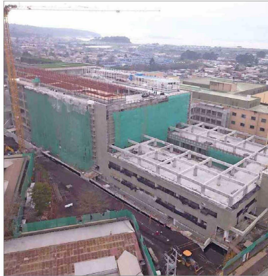
A marzo pasado, las obras del Hospital Las Higueras de Talcahuano llevaban un avance del 68%.
