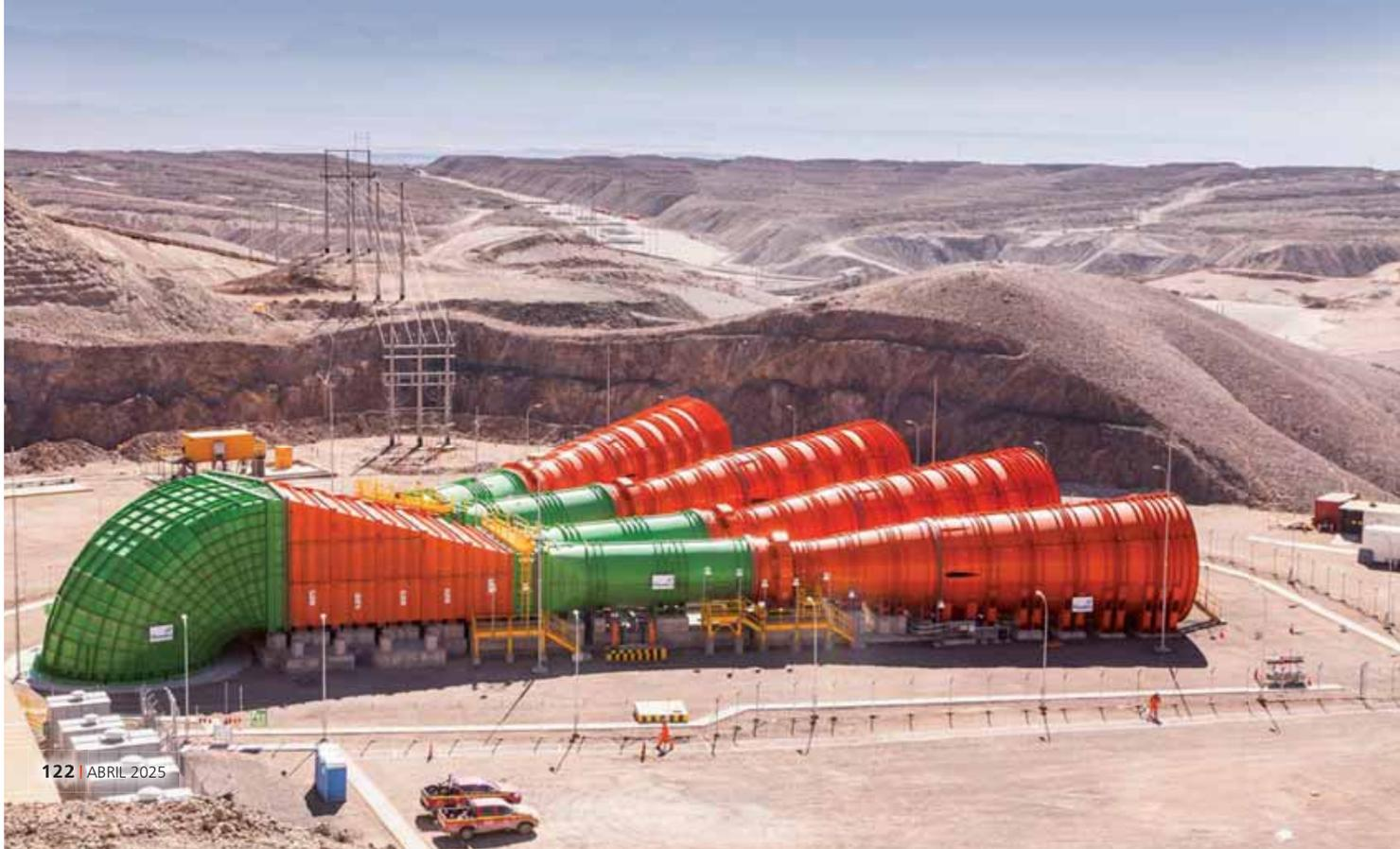
cada una de estas con sus respectivos sistemas de ventilación para construir. Durante el período de construcción existieron desafíos que se resolvieron mediante diseños de ingeniería, considerando algunas facilidades constructivas para llevar aire en calidad y cantidad suficiente hacia el interior de la mina antes del tiempo proyectado.
