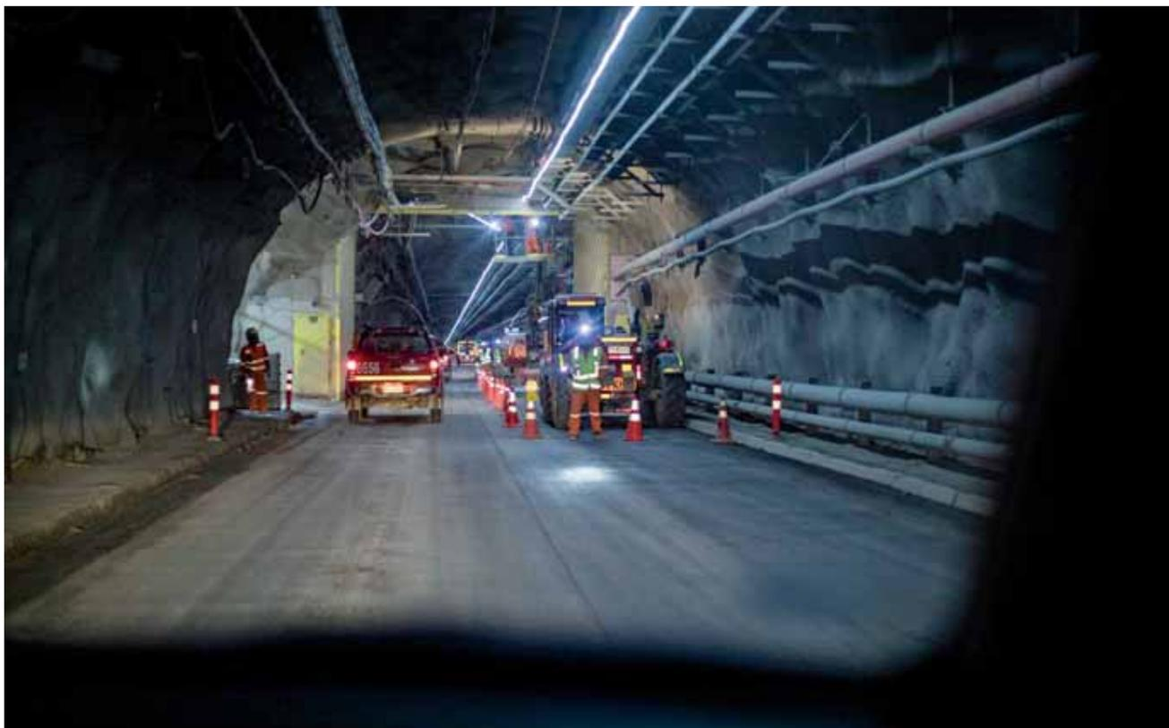
❖ Señala el ejecutivo de Codelco que durante el periodo de construcción existieron desafíos que se resolvieron mediante diseños de ingeniería, considerando algunas facilidades constructivas para llevar aire en calidad y cantidad suficiente hacia el interior de la mina.
