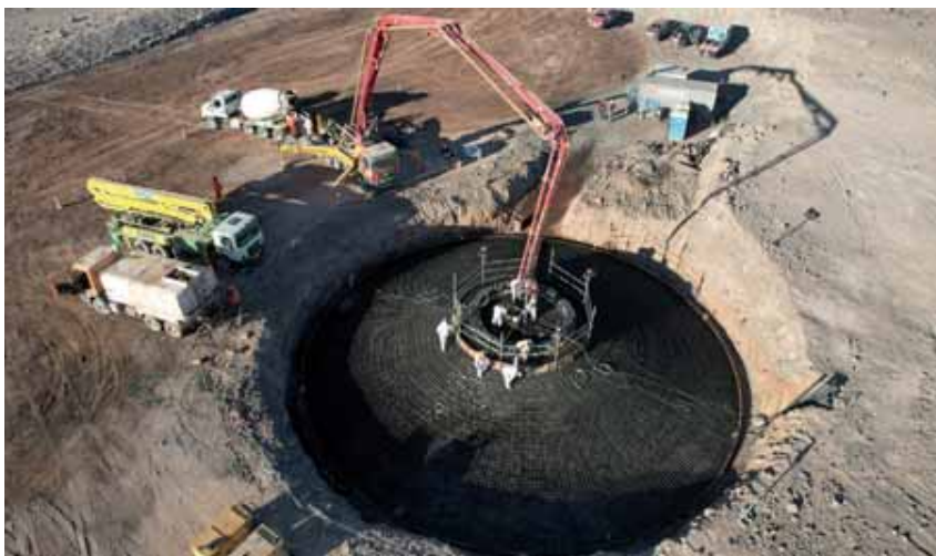
❖ En la base del aerogenerador se instala un encofrado para el vertido del hormigón.
