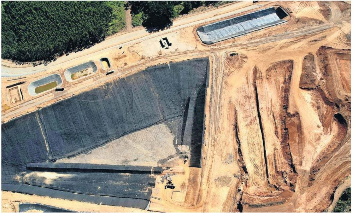
La celda nueva de Cemarc tiene mucha capacidad y está hecha con toda la tecnología disponible, cuenta con doble impermeabilización para más seguridad.
