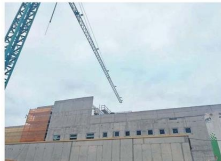
EL PRÓXIMO RECINTO ONCOLÓGICO TENDRÁ CINCO PISOS.
