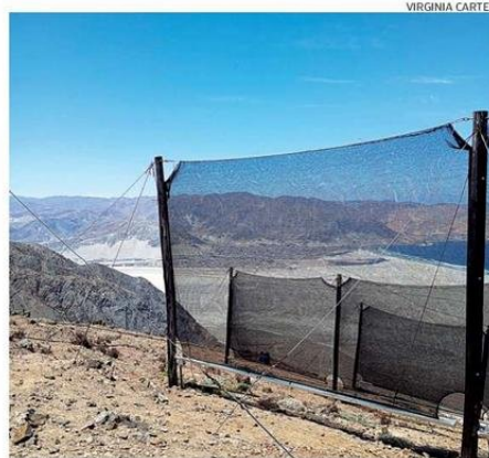
DOS POSTES SOSTIENEN LA MALLA CENTRAL QUE ATRAPA EL AGUA.
