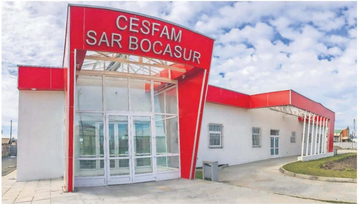
Se hizo la instalación de puertas, tabiques y vidrios blindados, así como láminas de seguridad e intercomunicadores en ventanillas.
