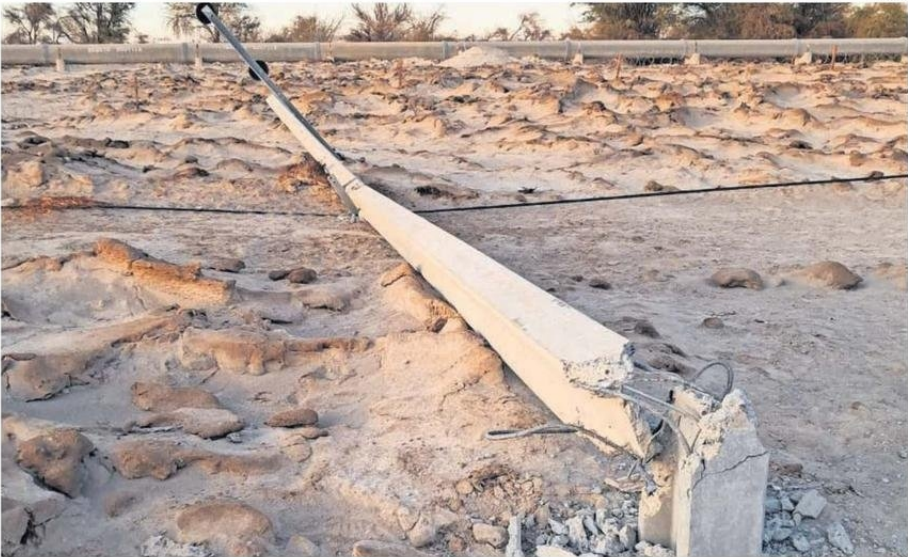
EL JUEVES CGE FINALIZARÁ LOS TRABAJOS EN EL SECTOR DE CANCHONES, RESTABLECIENDO EL SERVICIO NORMAL EN LA ZONA.
