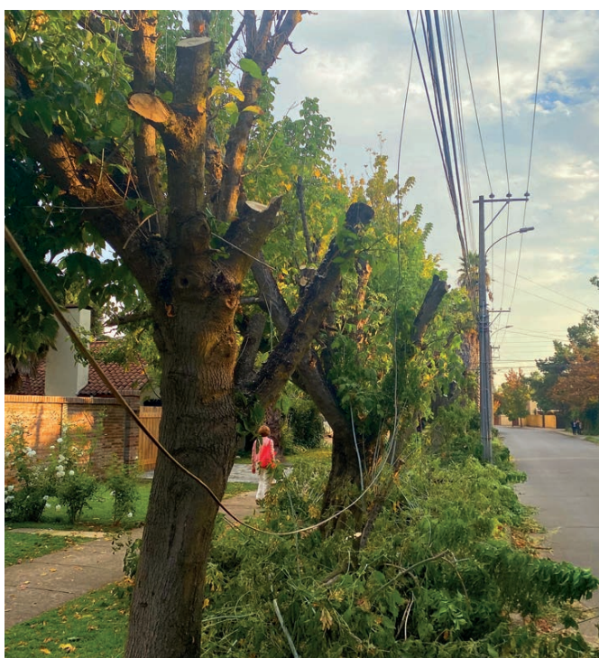
Malas prácticas en la poda de los árboles provocan severos daños a su estructura que podría generar daños irreparables, causando caídas de ramas e incluso la pérdida de todo el ejemplar.
