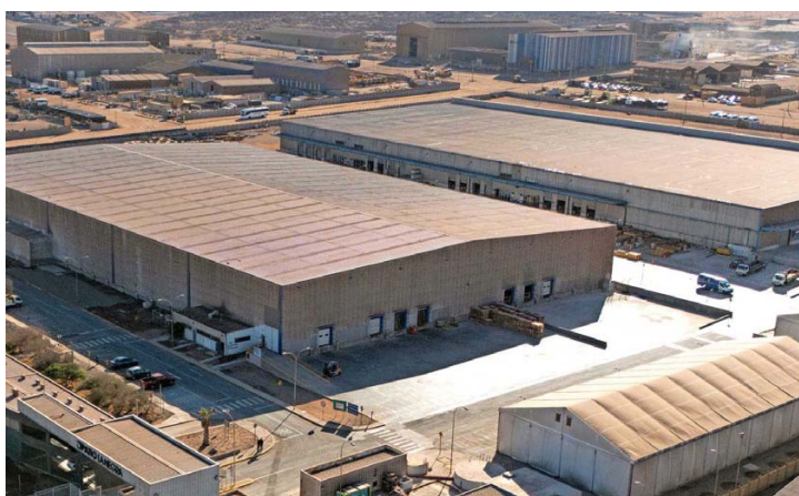
Hasta la fecha, Patio Industrial en el barrio La Negra se despliega sobre las superficies construidas de las etapas I y II, que suman un total de 28.000 m 2 .
