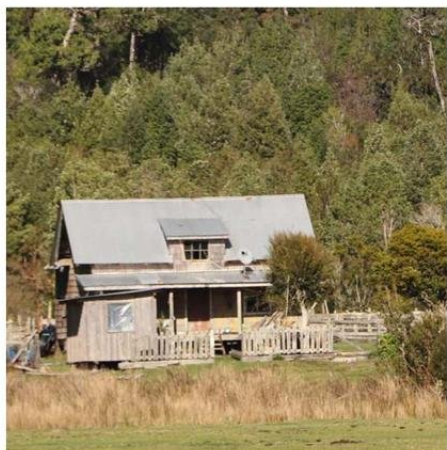
LAS CASAS EN LOS CAMPOS SUELEN ESTAR DETERIORADAS.
