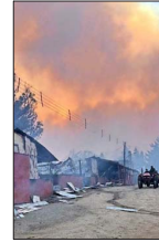
Liceo Suizo de Traiguén resultó destruido por el fuego.
