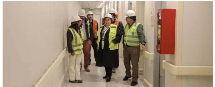
UNA DE LAS ÚLTIMAS VISITAS A LA OBRA POR PARTE DEL SERVICIO DE SALUD CHILOÉ, JUNTO A REPRESENTANTES DEL SERVICIO DE SALUD DEL RELONCAVÍ Y EL HOSPITAL REGIONAL DE PUERTO MONTT.
