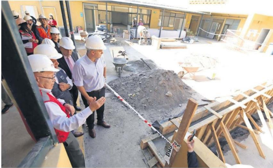
LOS TRABAJOS DE CONSERVACIÓN LLEVAN UN 45% DE AVANCE.
