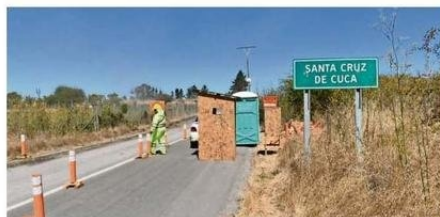
TRABAJOS LLEVAN UN 45% DE AVANCES.
