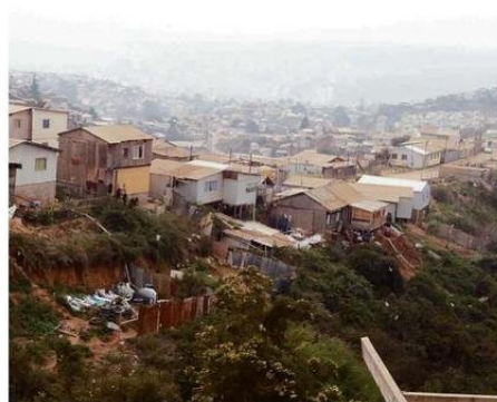
CHILE: 44% TOMAS EN TERRENOS DEL ESTADO Y 56% EN PRIVADOS.
