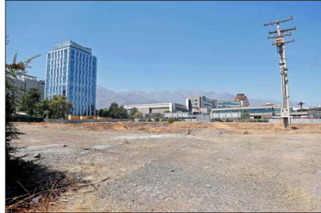
La empresa ha intentado levantar un proyecto en un paño de unos 22.500 metros cuadrados en avenida Kennedy frente al mall Alto Las Condes.
