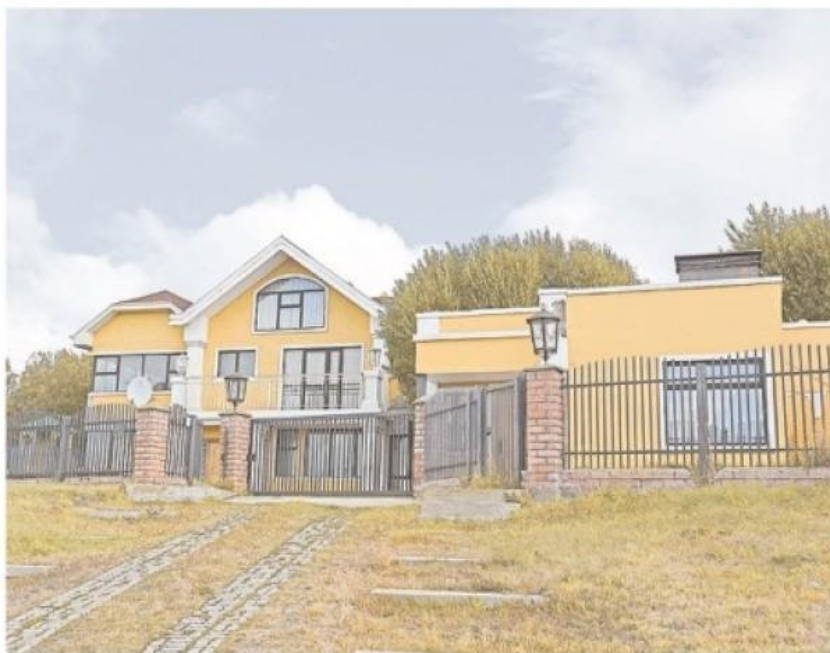
La casa ya fue adquirida por el gobierno regional y aún no ha sido entregada al Servicio de Protección Especializada para su habilitación.
