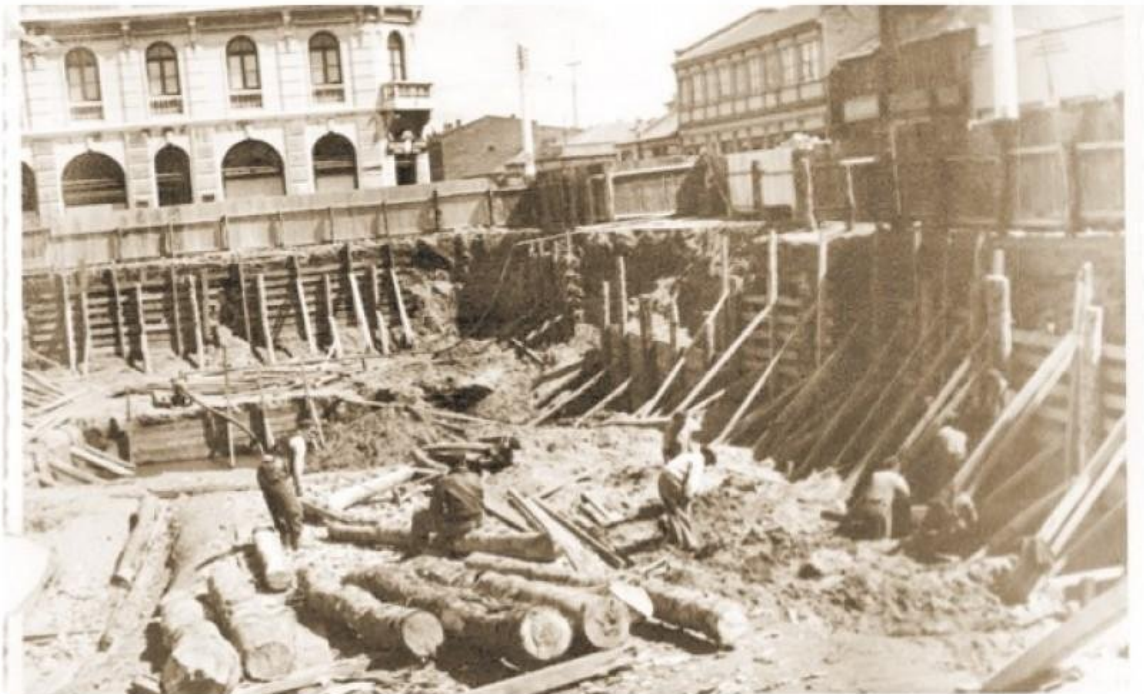
Obreros trabajan en las fundaciones del futuro edificio de Enap. Nótese que entre el conjunto de elementos estructurales figuraron troncos.
