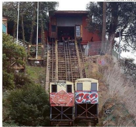
EL ASCENSOR ARTILLERÍA ES UNO DE LOS 8 QUE NO FUNCIONAN.
