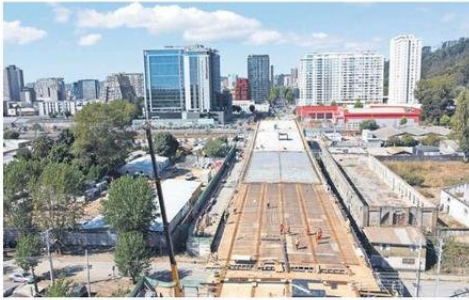
Avanza el hormigonado de la superficie de la conexión del puente.
