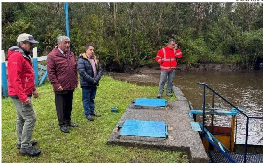
EL JEFE COMUNAL Y OTROS FUNCIONARIOS LLEGARON AL CENTRO DE CAPTACIÓN PARA VERIFICAR EL PROBLEMA.
