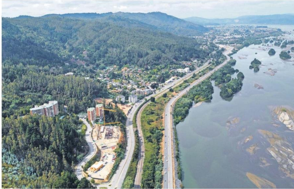
La intervención contempla dotar de cuatro pistas el tramo de la costanera que considera desde av. Binimelis hasta 8 Oriente.
